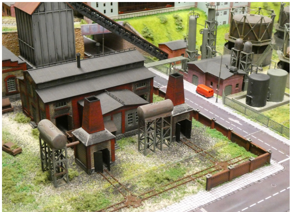
Die alte Kokerei: vorn zwei Löschtürme, dahinter der Hochbunker mit Schrägaufzug für Steinkohle rechts die Gaswäscher
